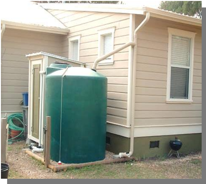
شكل رقم (4): نماذج لنظام حصاد مياه المستجمع الصغير في المدن .
