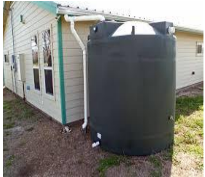
شكل رقم (4): نماذج لنظام حصاد مياه المستجمع الصغير في المدن .
