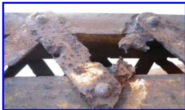
الانهيارات الناتجة عن تآكل المعادن
