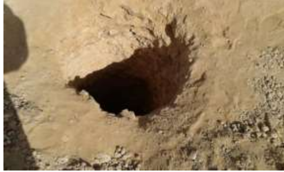
اللوحة عدد3: بئر نشو، تنفيذ الفتحة في الطبقة الصخرية- وادي صخر-مطروح2018
