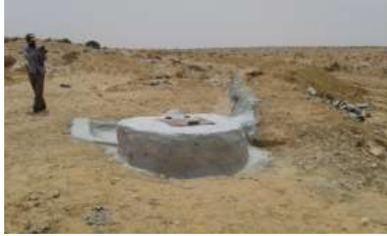
اللوحة عدد 4 : بئر لتخزين مياه الأمطار مع وضع غطاء حديدي على فتحة وادي صخر- مطروح 2018.
