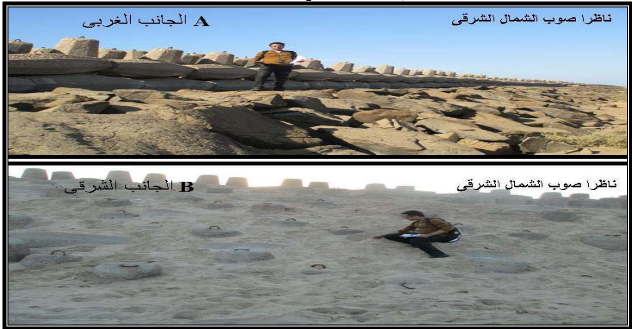
صورة ( 1 ) حواجز الحماية على جانبي منطقة الدراسة ( ناظرا صوب الشمال الشرقى ) .
